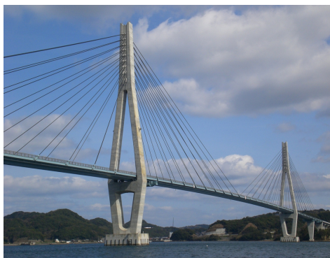
鷹島肥前大橋（松浦市・唐津市）
