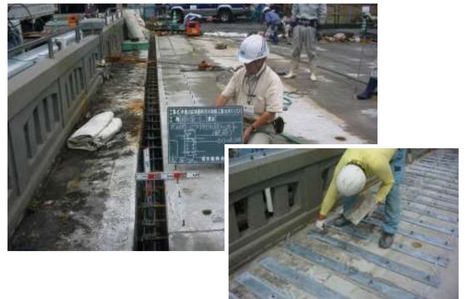
(新設桁と既設高欄部接合)
