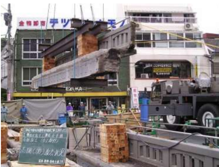
(高欄部切断移設状況)
