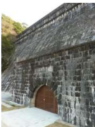
(写真) 堤体下流面
