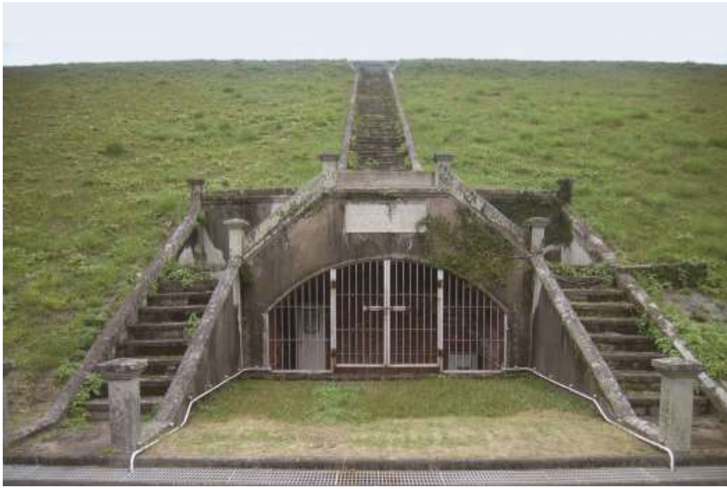
(写真) 堤体下流面
