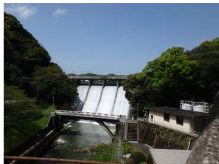
(写真) 浦上ダム下流から
