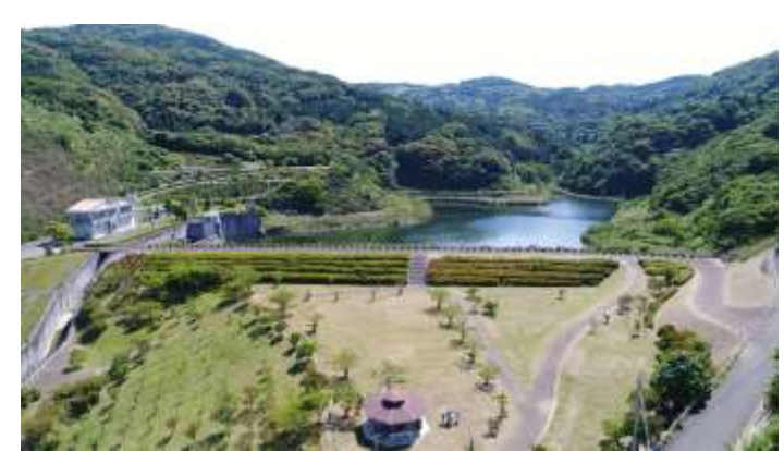
宮崎ダム（アースダム）（所在地：長崎市）
