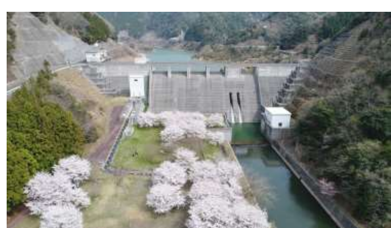
目保呂ダム（重力式コンクリートダム）（所在地：対馬市）
