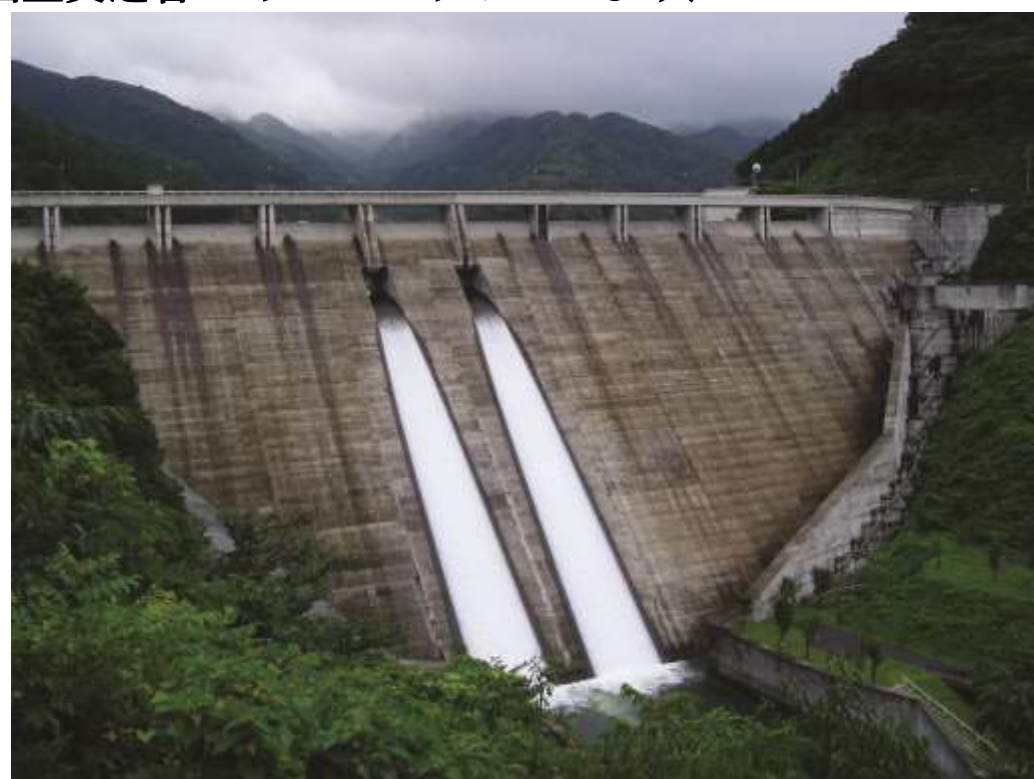
萱瀬ダム（所在地：大村市）
