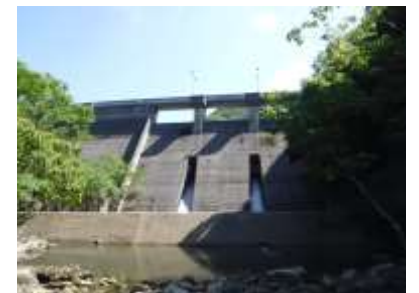
（ゲートレスダム）仁田ダム 〈所在地：対馬市〉
