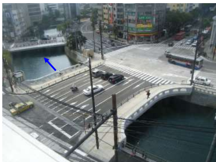
(中央橋完成：平成21年10月)
