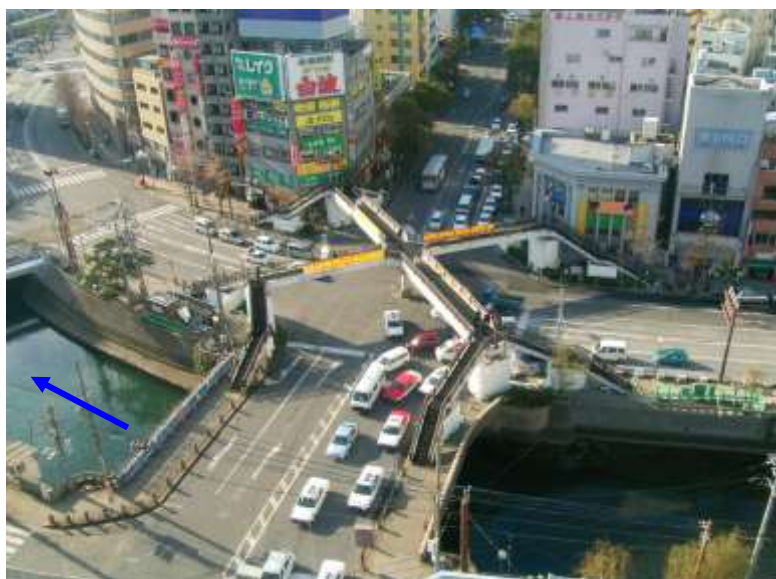
(着工前：平成19年2月)
