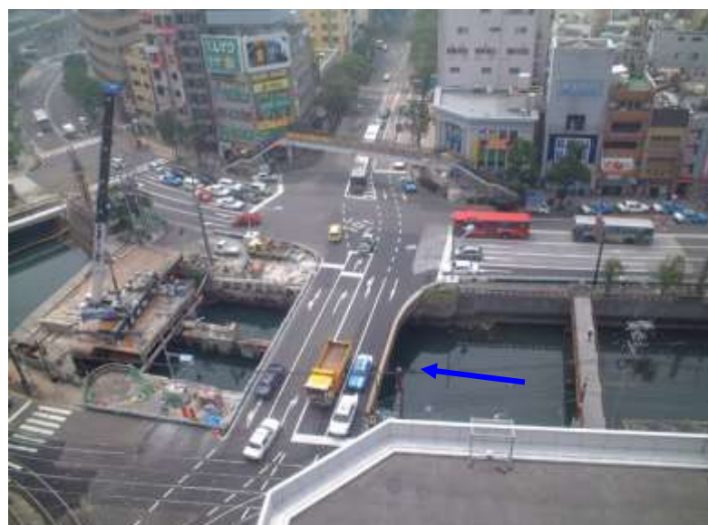
(橋梁下流側施工：平成19年6月) 橋梁工事は、上下流の2分割施工で実施。 下流側施工時は、旧橋の半分を迂回路として利用。
