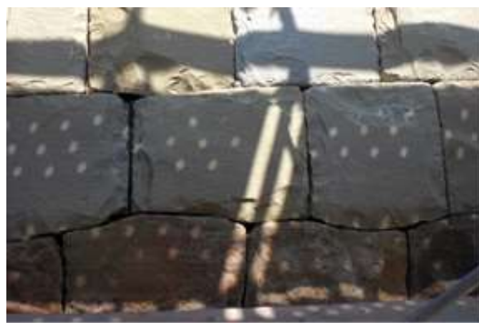
(新材の目地のうねり調整)
