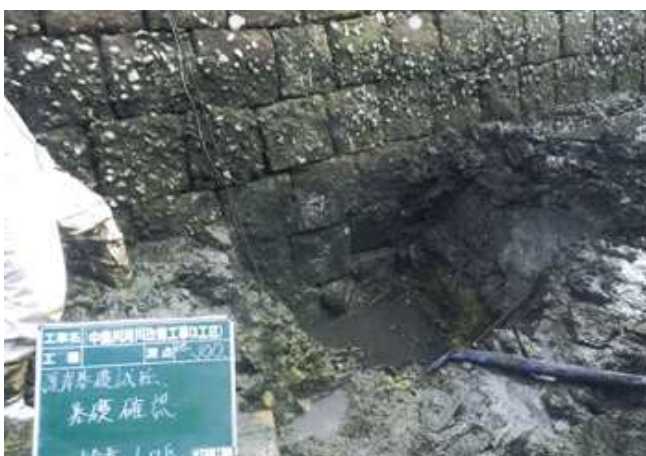
(トレンチ掘削状況)
