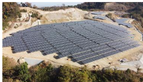
イワテック第六ソーラー発電所
