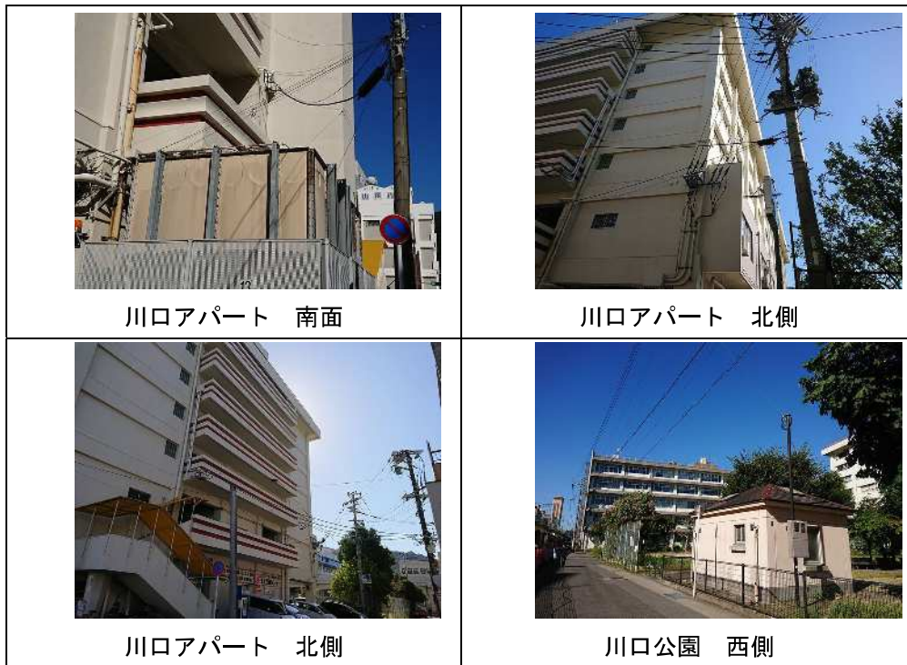
街区周囲の電柱引込位置
