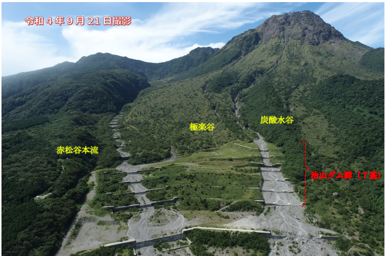
写真1：赤松谷本流・極楽谷・炭酸水谷の状況 全景
