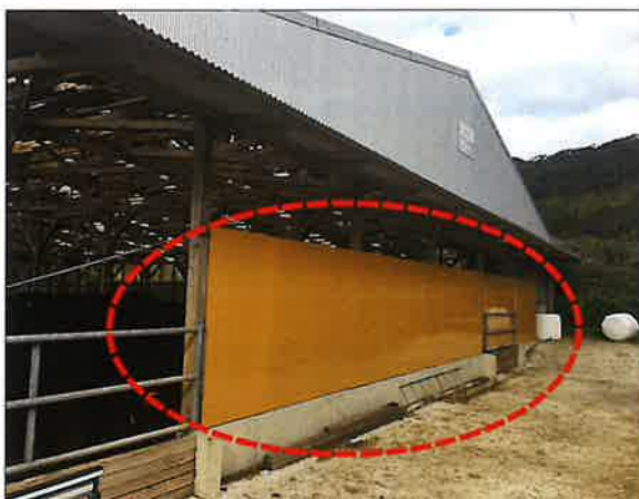
北風が直接吹き込まないように コンパネを設置した例
