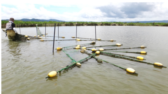
図 9 2020年7月6日に発生した豪雨災害後、7月22日の進出工内の波浪軽減施設(水平張り)の状況
