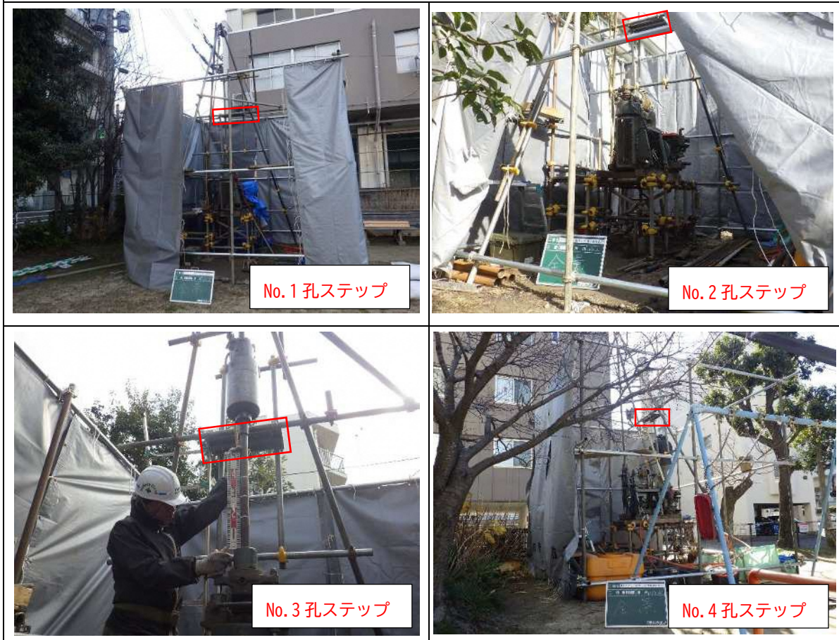
各孔のステップ作業場の設置状況
