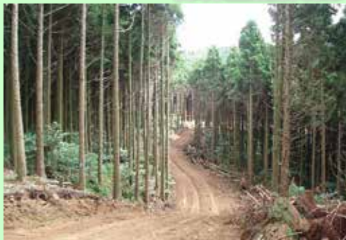
森林作業道開設状況
