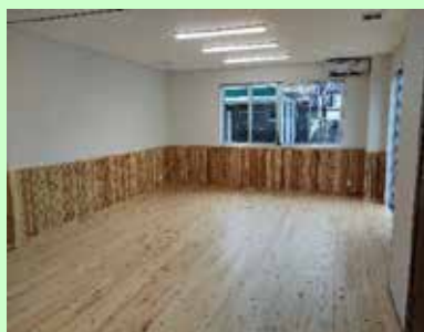
保育スペースの木質化
