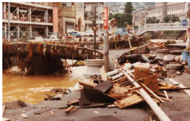
伊良林小学校付近の道路の被災
