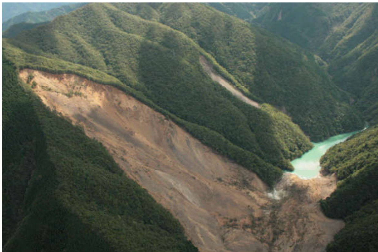
台風12号によって崩れた土砂による河道閉塞 提供：国土交通省近畿地方整備局 (奈良県五條市大塔町 赤谷、2011(平成23)年9月13日撮影)
