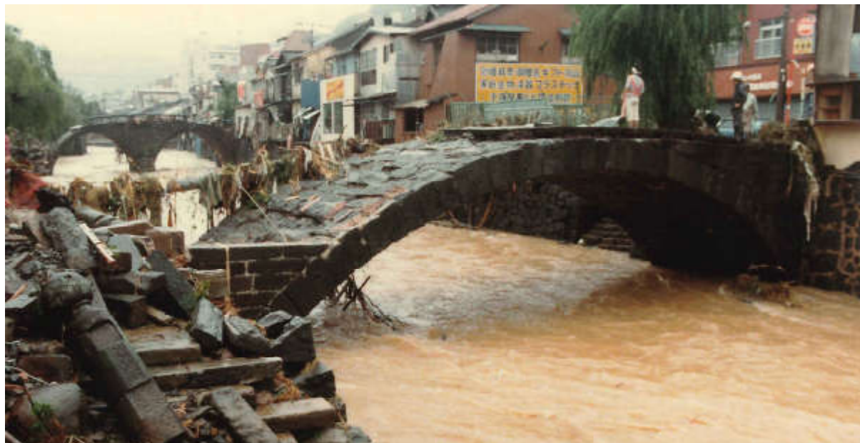
被災した眼鏡橋と袋橋（手前）
