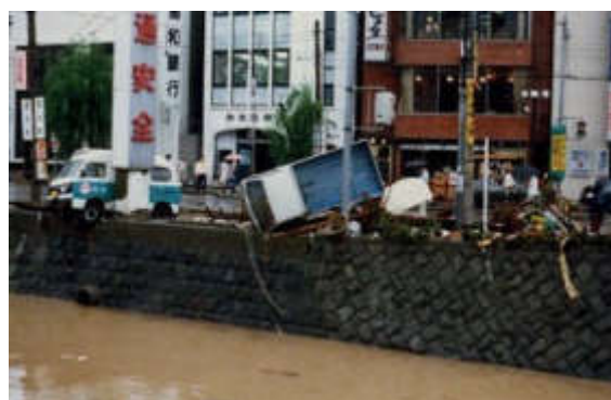
被災車両等による道路の寸断の状況。道路の寸断で、緊急車両等が通行できず、初動を困難にしました。
