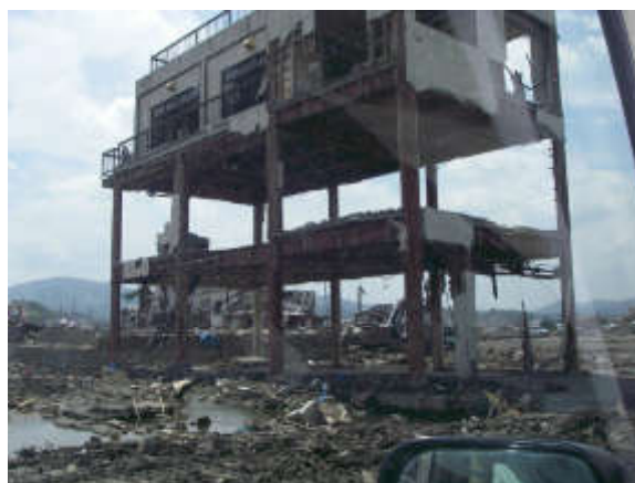
被災した気仙沼市内の建物 提供：原道泰氏(長与町在住)
