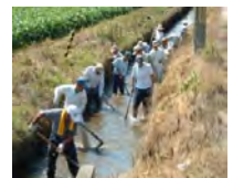
水路の泥上げ
