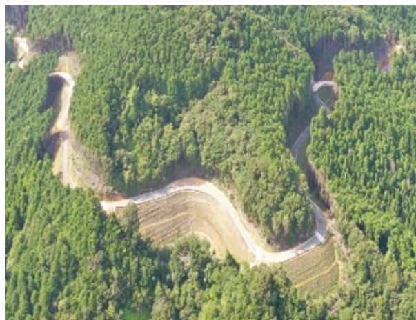
効率的な木材搬出のための林道整備
