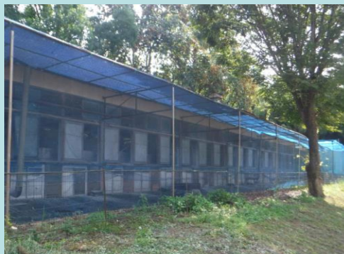
野生動物侵入防止のためのネットの設置
