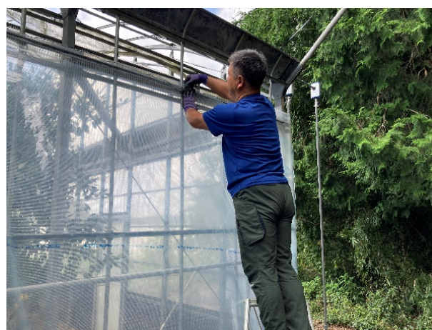
ハウスの張り替え作業
