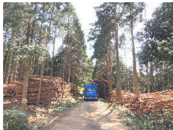
搬出間伐材集積状況
