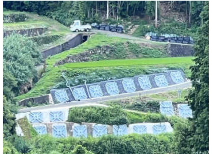
地すべり防止工事(アンカー工)
