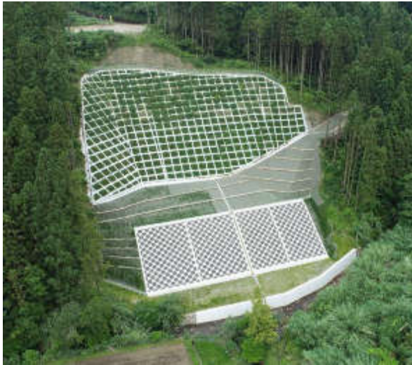
治山工事(法枠工・土留工)
