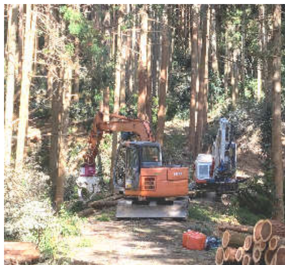
高性能林業機械による作業
