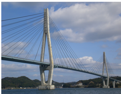
鷹島肥前大橋（松浦市・唐津市）
