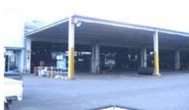
交通局中央整備工場（諫早市）
