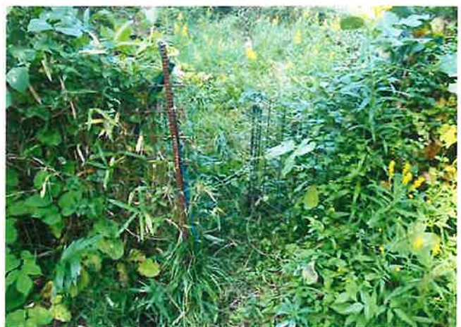
開閉部の破損
