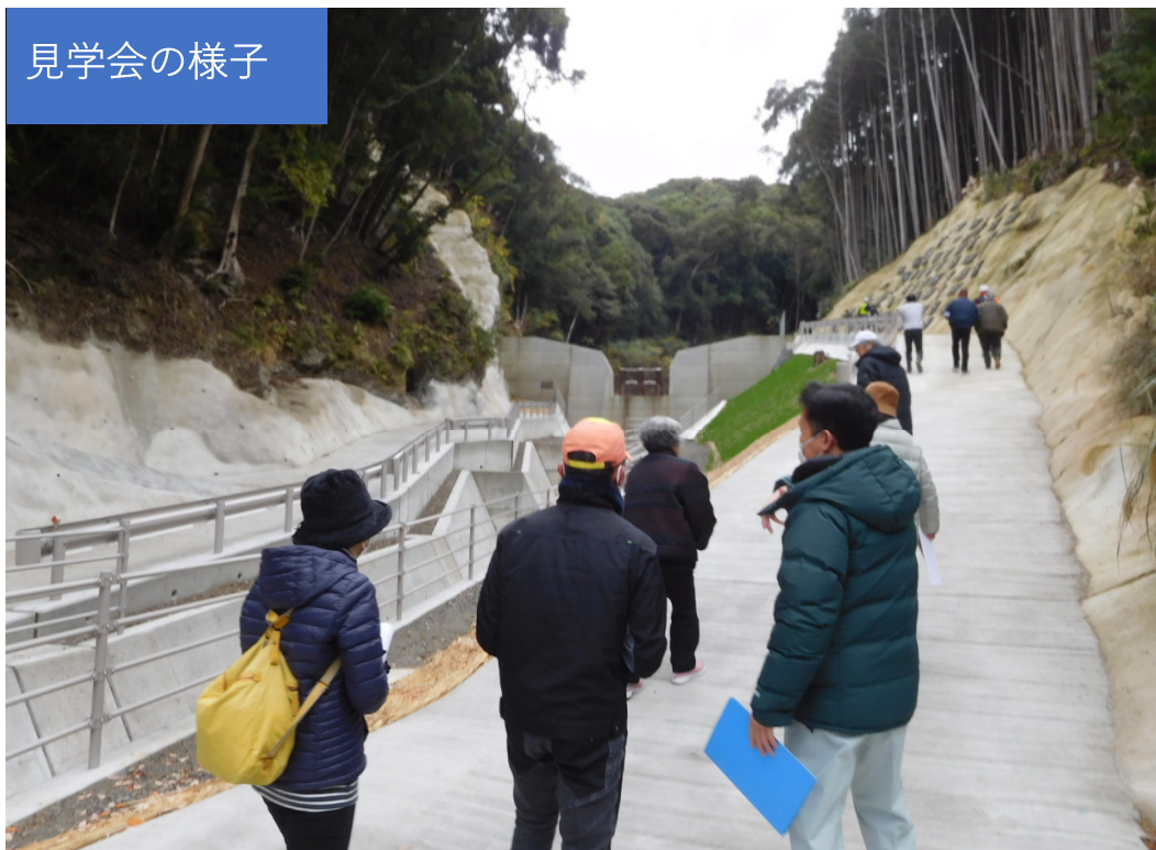
左岸管理用道路
