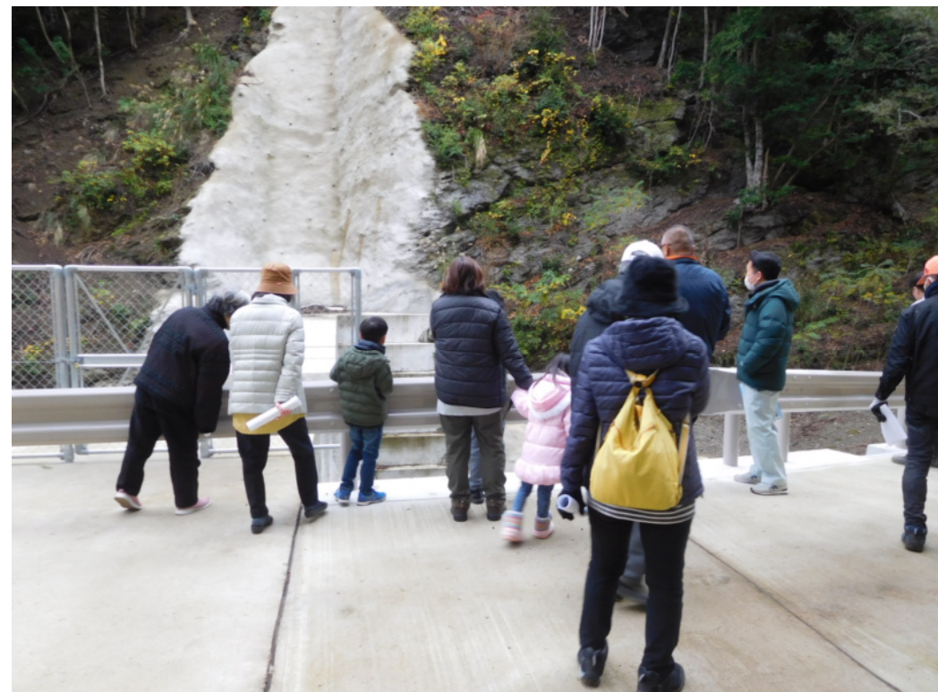
堰堤側面上部
