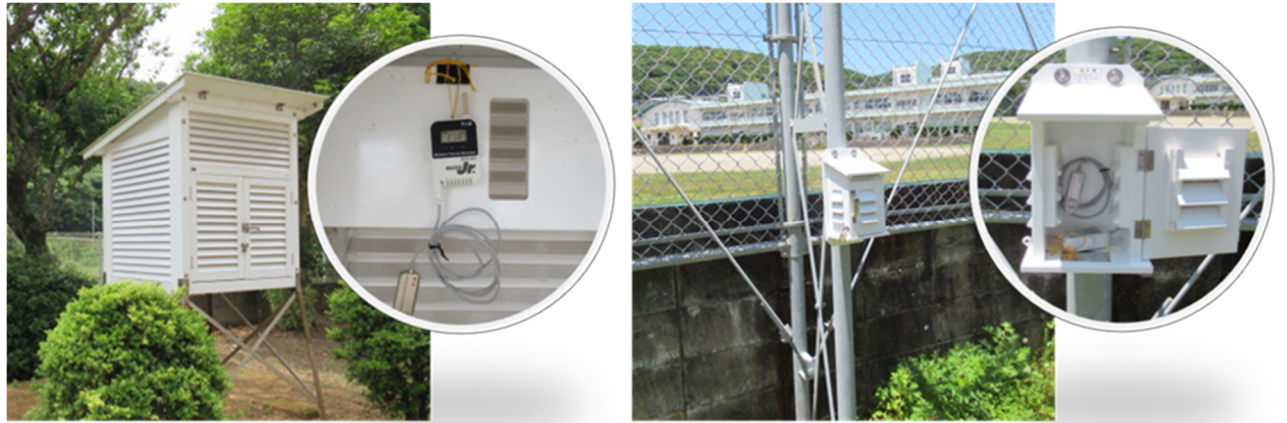
図4 データロガーの設置状況
