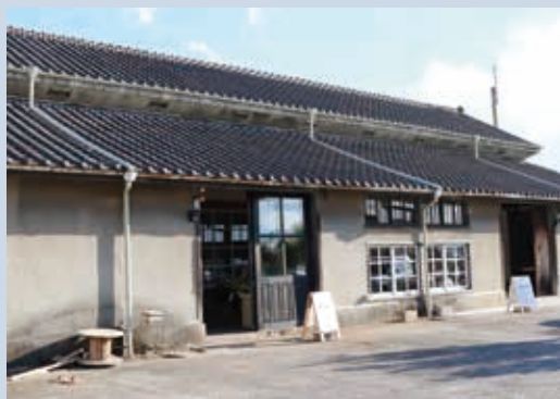
旧千綿村農協米倉庫 (Sorriso riso) 提供：東彼杵町
