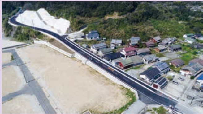
国道 384 号改良 (黒瀬工区)
