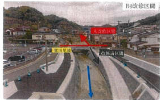
はこね橋上流側の状況
