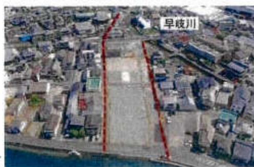
早岐川の工事予定箇所
