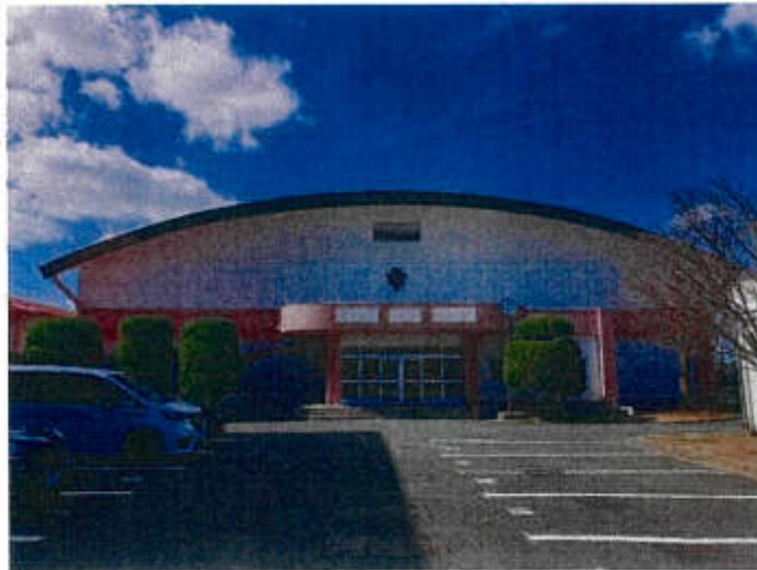
建物全景（正面玄関）
