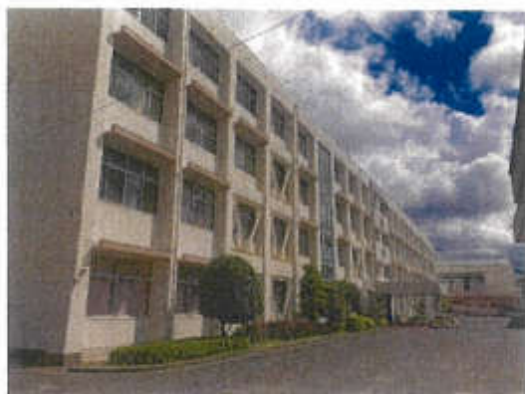
着工前 (南西面)
