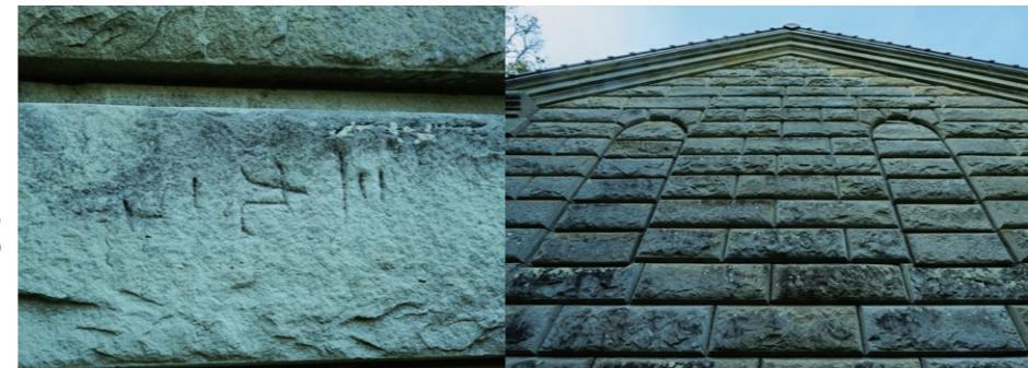
教会堂の裏手で見られる窓枠の跡
