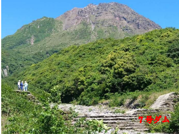
写真-2：7号治山ダムの堆砂状況
