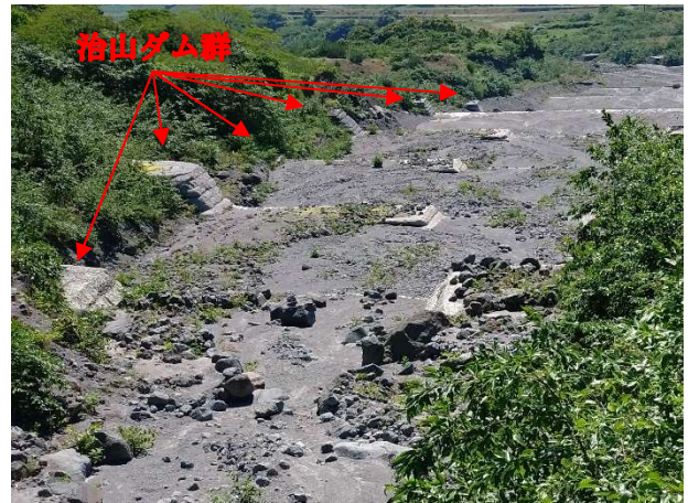
写真-3：7号ダム右岸より下流のダムを望む
