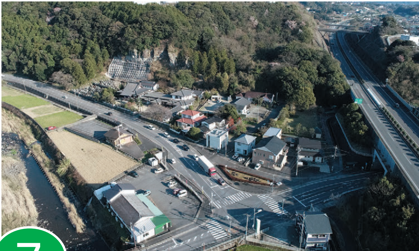
景観に配慮した山腹斜面の法面対策工事
