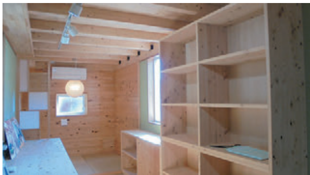
スマートモジュールの内装
