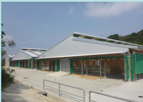
畜産クラスター構築事業による牛舎整備
