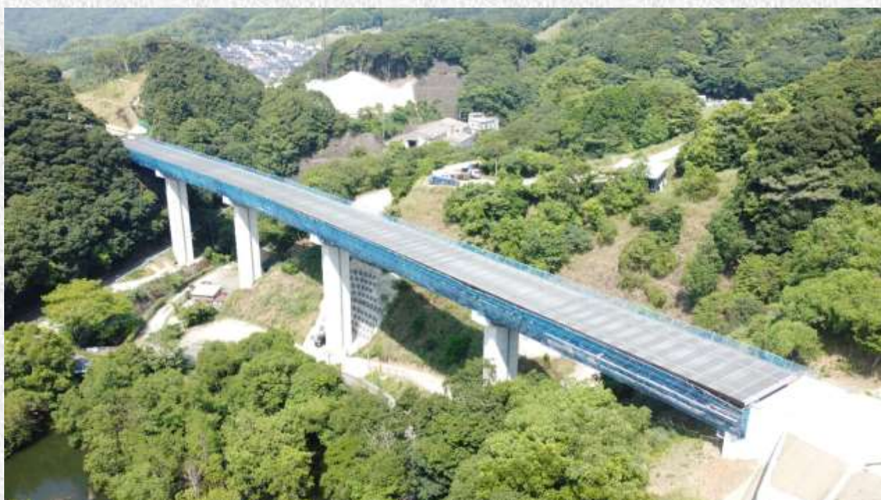
主要地方道長崎南環状線道路改良工事（新戸町～江川町工区）
