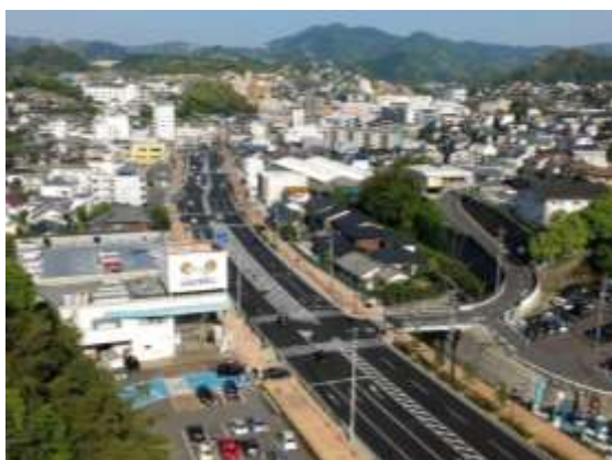
横道工区の供用状況
