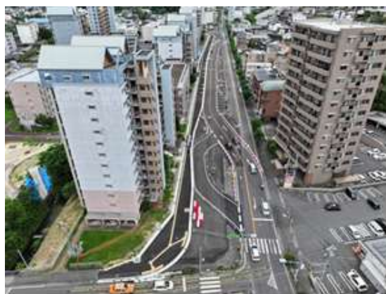
大神宮工区の工事状況
