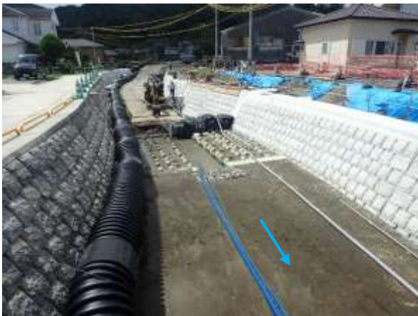
令和4～6年度施工（護岸工）
