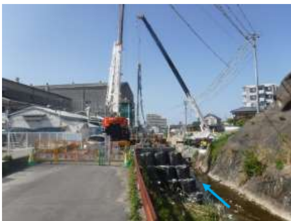
令和4年～6年度施工（護岸工・法面工）
