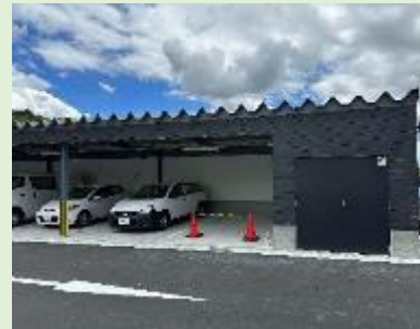
倉庫兼駐車場 (広島県動物愛護センター)
