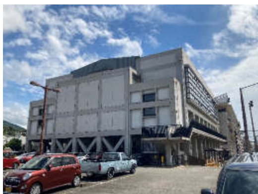
着工前（北西面）
