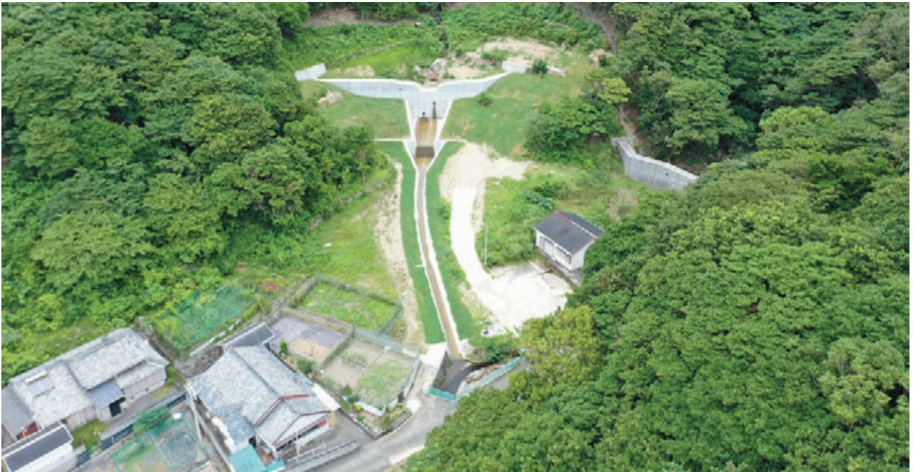
五島市 奈留町 やがみ 矢神地区（治山事業施工事例）
