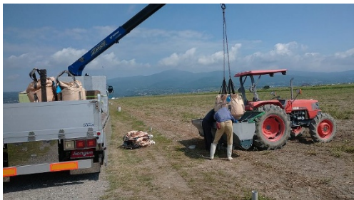
【トラッククレーンによるタンクへの投入】
