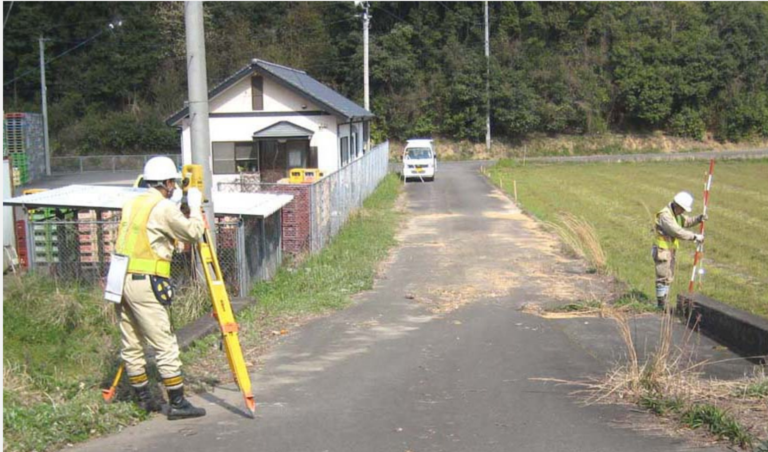
測量作業の様子
