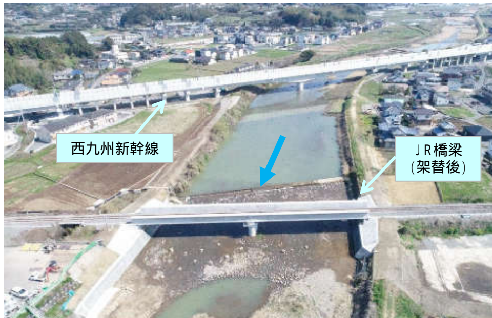
郡川河川改修工事（改修状況）
