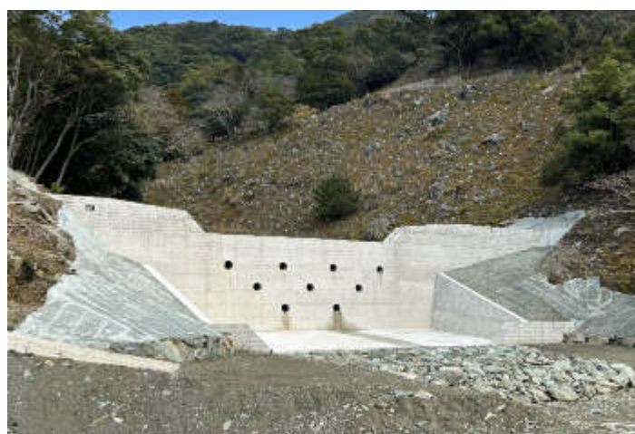
治山工事実施箇所（長崎市）
