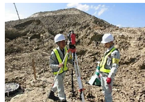
建設現場実習
