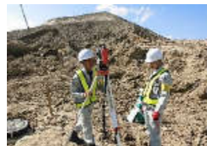
建設現場実習
