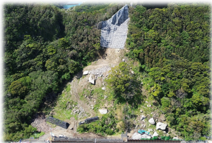
（ 山地災害を防ぐための治山工事 ）
