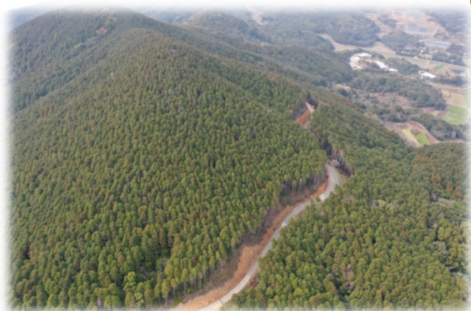
（ 林業専用道の開設工事 ）
