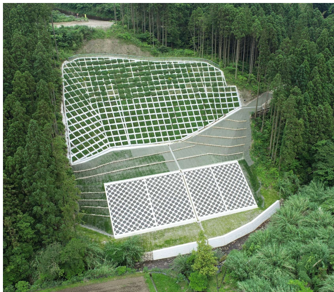
（ 山地災害を防ぐための治山工事 ）
