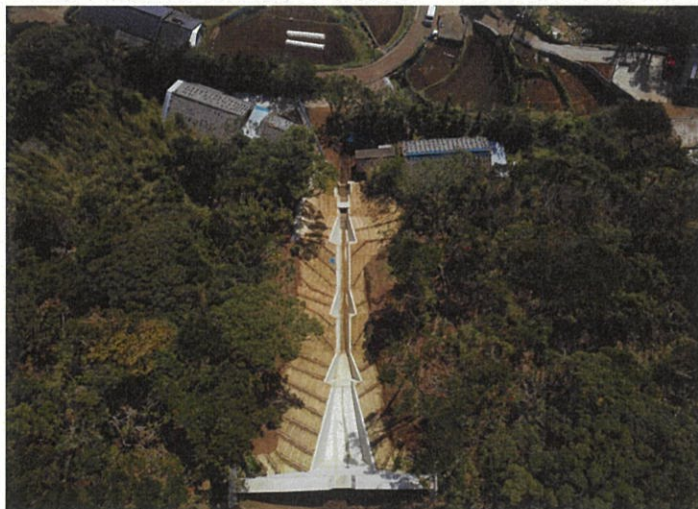
（ 山地災害を防ぐための治山ダム ）
